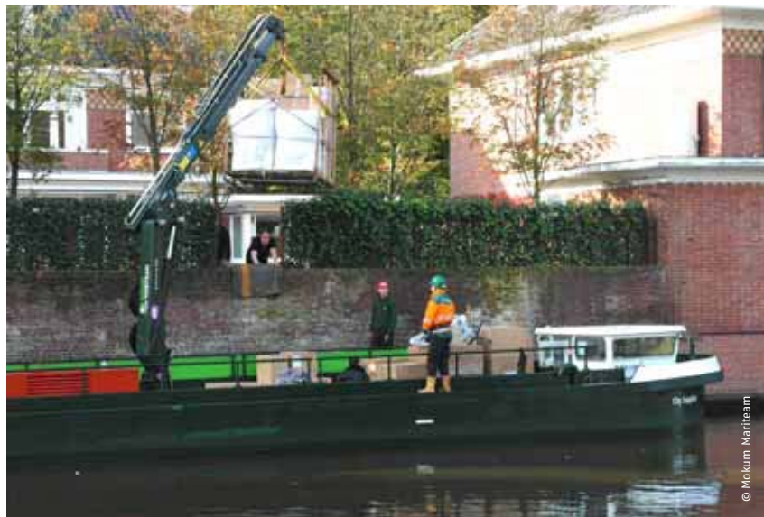
Vervoer van bouwmaterialen via de grachten in Amsterdam.
